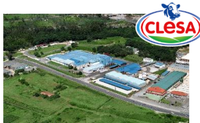
Planta productos refrigerados Caldas de Reis
