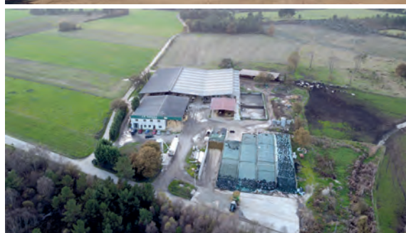
Vistas de las tres instalaciones, de arriba a abajo, Reigada, Chaín y Xerlea
