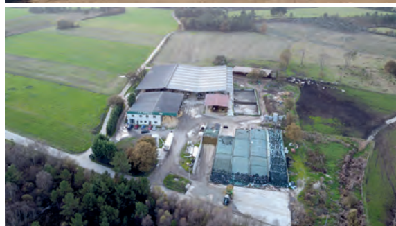
Vistas das tres instalacións, de arriba a abaixo, Reigada, Chaín e Xerlea
