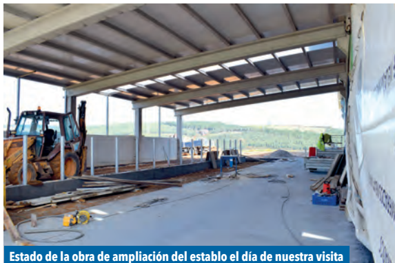
Estado de la obra de ampliación del establo el día de nuestra visita
