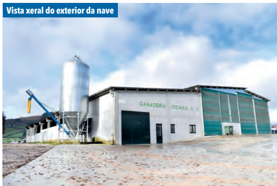
Vista xeral do exterior da nave
