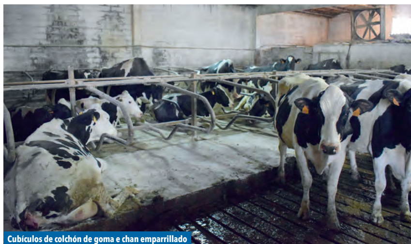
Cubículos de colchón de goma e chan emparrillado
