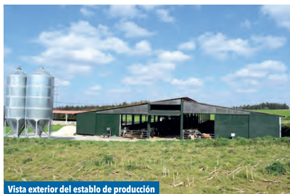
Vista exterior del establo de producción
