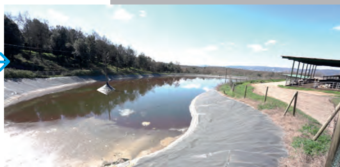
Balsa receptora da parte líquida que fertilizará os campos
