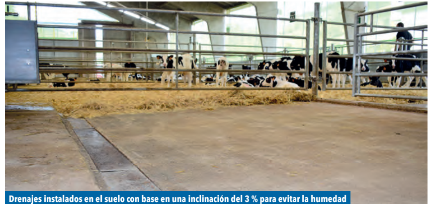
Drenajes instalados en el suelo con base en una inclinación del 3 % para evitar la humedad
