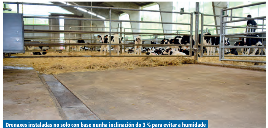
Drenaxes instaladas no solo con base nunha inclinación do 3 % para evitar a humidade
