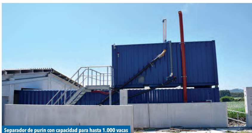
Separador de purín con capacidad para hasta 1.000 vacas
