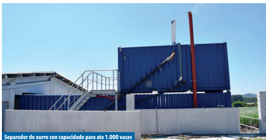
Separador de xurro con capacidade para ata 1.000 vacas
