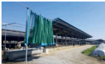
2. Una cortina móvil como escudo contra la penetración de la radiación solar en el pesebre de una pequeña granja lechera familiar en el norte de Italia
