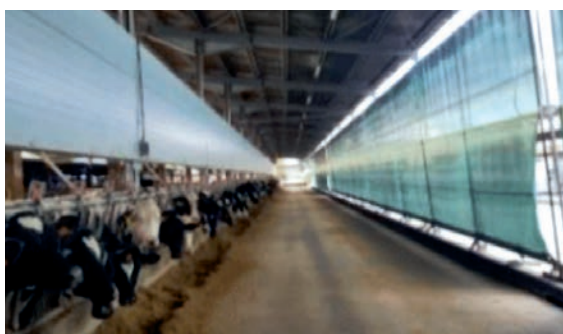
1. Una "cortina de malla" como escudo contra la penetración de la radiación solar en el pesebre de una gran granja lechera en el sur de Italia
