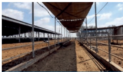
7. Bebedoiros instalados nos corredores á sala de muxido nunha finca localizada no sur de Israel
