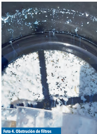
Foto 4. Obstrución de filtros
