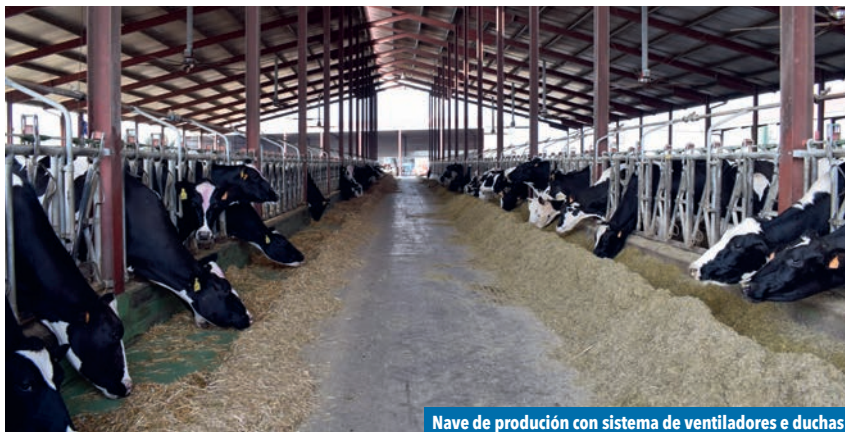
Nave de produción con sistema de ventiladores e duchas
