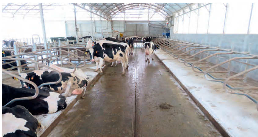
Imagen 7. Cubículos con las mismas medidas a excepción de la barra educadora. En la línea de la derecha, la barra educadora está colocada 5 cm más baja en altura con respecto a la línea de cubículos izquierda
