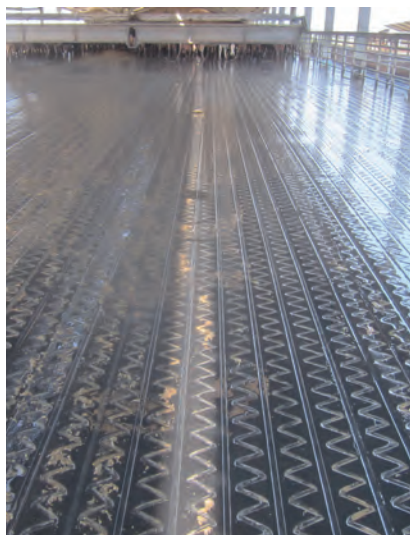
Imagen 5. Sala de espera con suelos de goma con un tipo de rallado que aumenta la tracción
