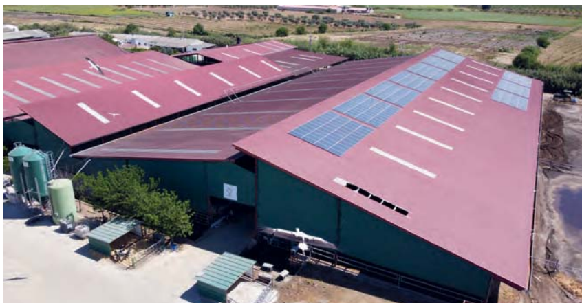
Todas las placas son para autoconsumo, porque la línea que pasa por su zona ya está saturada y no les permiten vender nada
