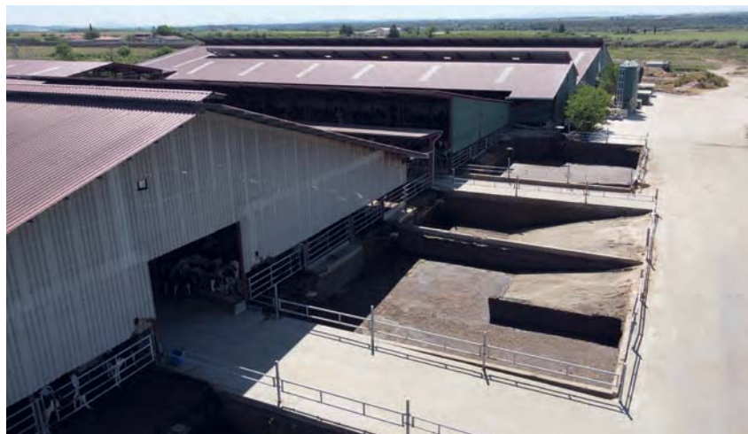
Con estas catro fosas dispoñen dunha capacidade total de 3.000 m 3
