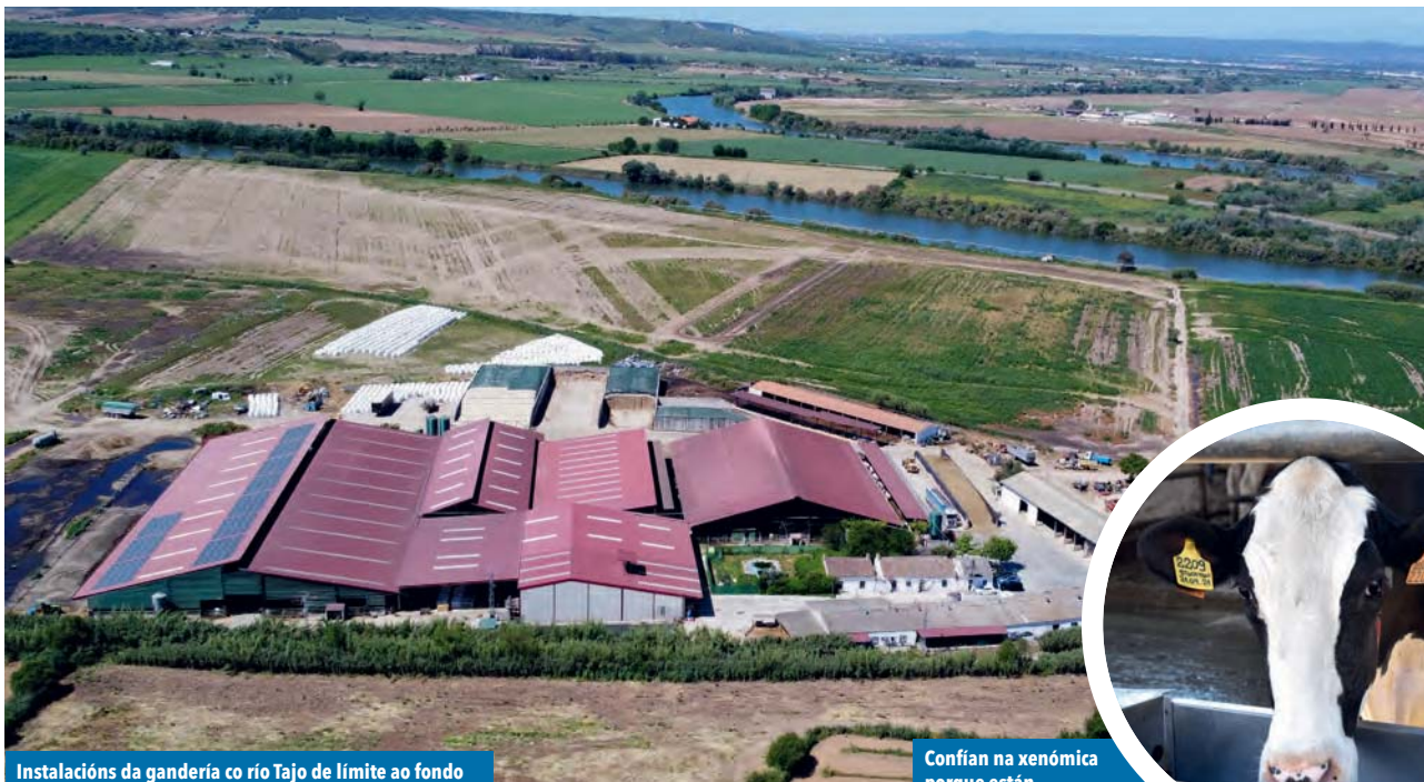
Instalacións da gandería co río Tajo de límite ao fondo
