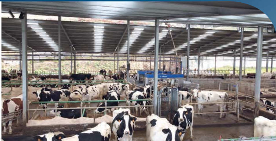
Han construido una nueva nave pensando ya en la instalación de cuatro unidades de ordeño robotizado
