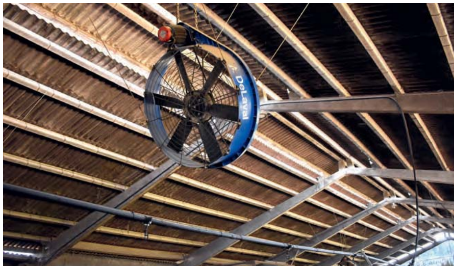
Las vacas se hacinaban en la parte más fresca de la nave y, al instalar el sistema de ventilación y duchas, solucionaron el problema
