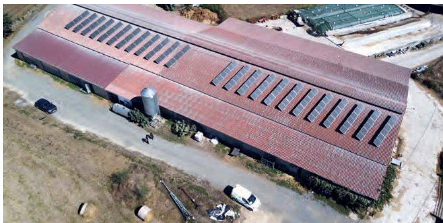
Gracias a las placas solares notan un ahorro considerable, sobre todo en las épocas en las que la luz sube de precio
