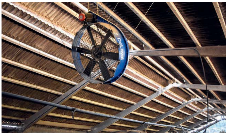
As vacas amoreábanse na parte máis fresca da nave e, ao instalar o sistema de ventilación e duchas, solucionaron o problema
