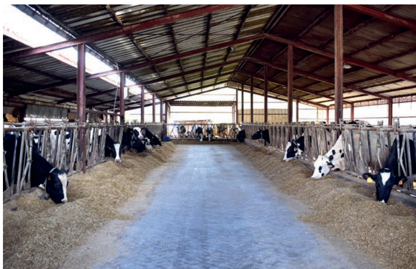
Atajaron el problema del estrés por calor colocando ventiladores y sistemas de frío
