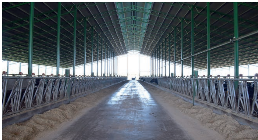
La nave principal, de actual construcción, tiene unos 9.000 m 2 techados
