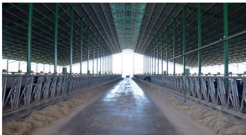
A nave principal, de actual construción, ten uns 9.000 m 2 teitados
