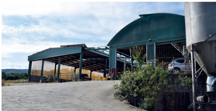
Instalacións actuais construídas en 2012 e ampliadas en 2019
