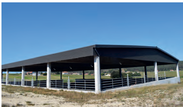
La fosa cubierta de la nave de producción suma 11,5 millones de litros de capacidad
