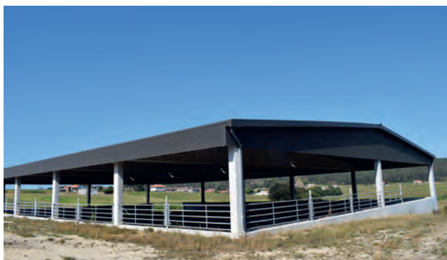
A fosa cuberta da nave de produción suma 11,5 millóns de litros de capacidade
