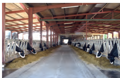
Ampliación da nave de produción
