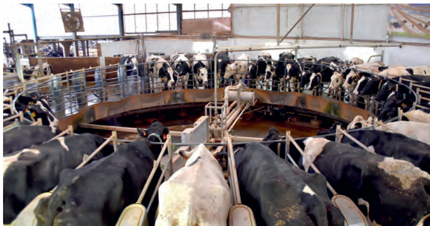
Moxen nesta sala rotativa de 40 puntos instalada en 2013
