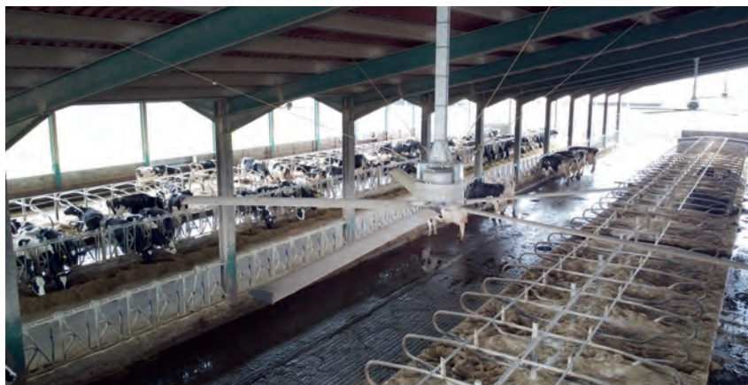
Instalaron ventiladores por toda a nave o verán pasado para loitar contra os efectos do estrés por calor
