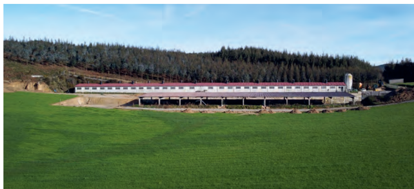
Nave para el porcino de cebo con capacidad para 1.200 plazas
