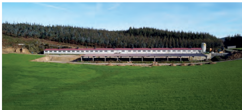
Nave para o porcino de ceba con capacidade para 1.200 prazas
