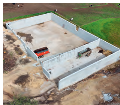
Están terminando la construcción de una nueva fosa y así sumarán alrededor de 10 millones de litros de capacidad total
