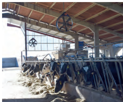
Instalou ventiladores e aspersores de auga porque perdía tres ou catro litros por vaca no verán e agora o impacto é moito menor
