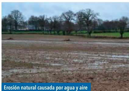
Erosión natural causada por agua y aire
