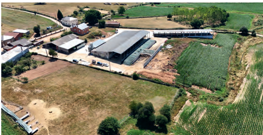
Su siguiente inversión será la instalación de placas solares en la nave de lactación antes de que finalice 2026
