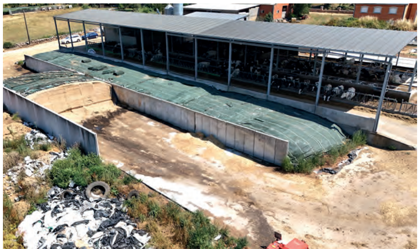
A lonxitude dos silos e o acceso desde ambos os extremos permiten separar diferentes cortes ou campañas e manter unha fronte de consumo adecuada
