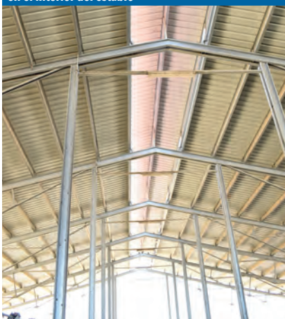
La apertura cenital del tejado favorece la ventilación en el interior del establo
